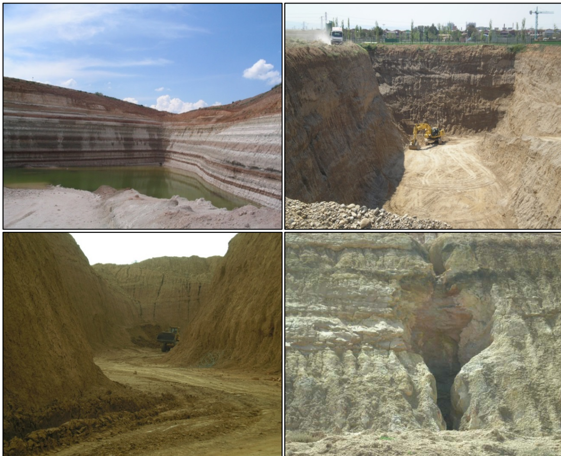
Figura 11. Distintos grados de erosión en taludes de huecos mineros
