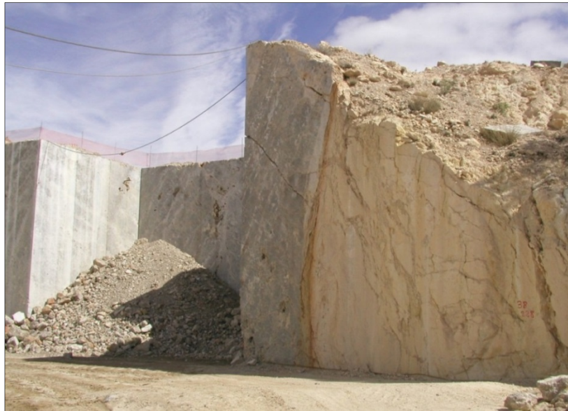
Figura 22. Discontinuidad geológica en un talud vertical en los límites de una cantera de mármol comercial (Sierra de las Andaluzas, Murcia). Se distingue un cambio neto de la roca competente (gris) a un material mucho más blando y deleznable (beige)
