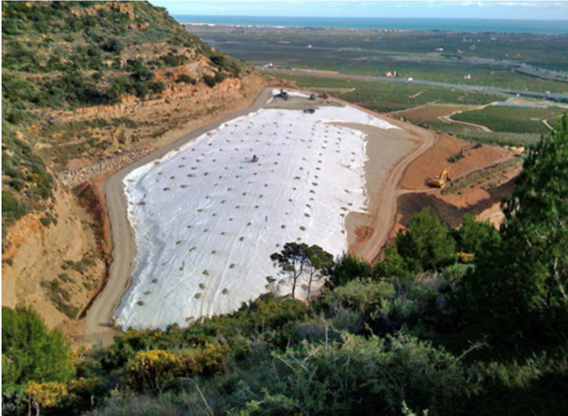
Figura 5. Sellado final de un vertedero
