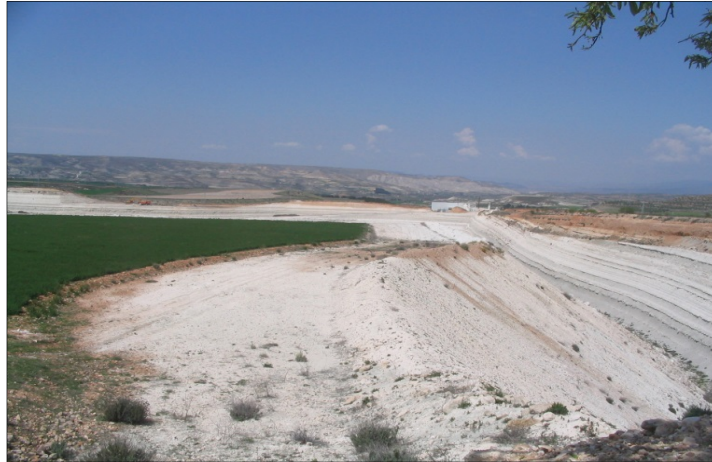
Figura 6. Relleno y rehabilitación del hueco de una explotación de sepiolita mediante la transferencia de los estériles en Calatayud (Zaragoza).
