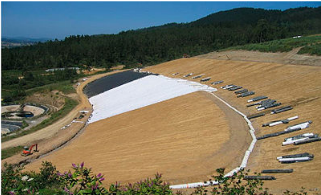
Figura 3. Instalación de geomembrana en talud
