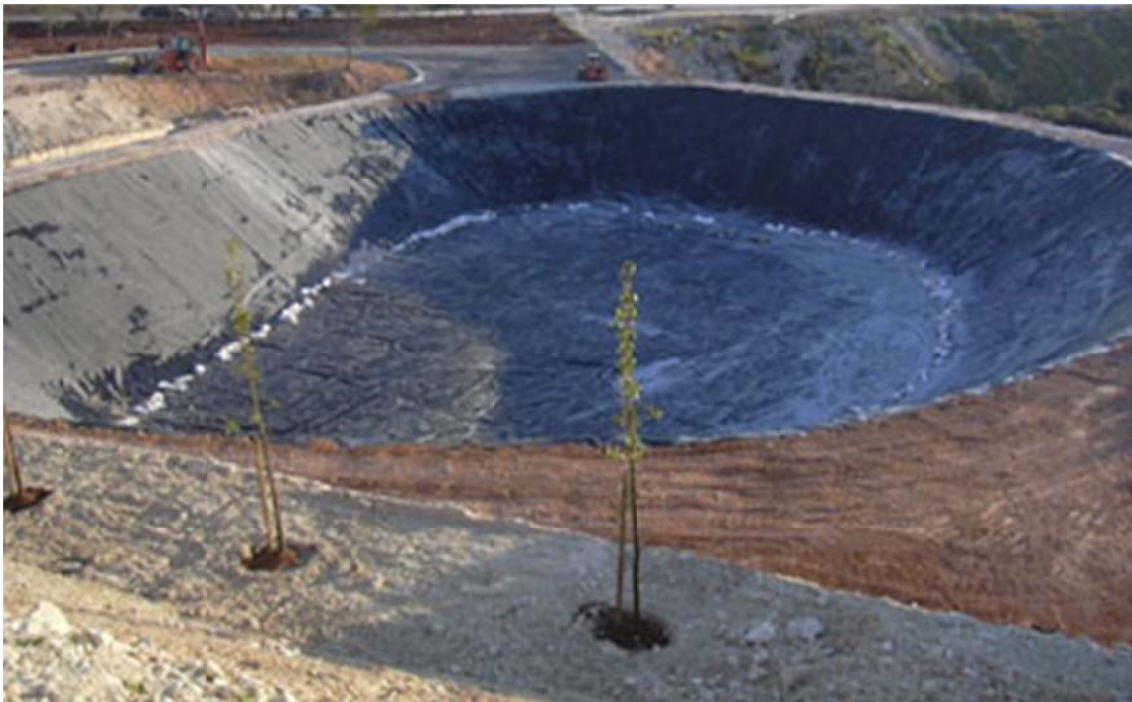
Figura 4. Balsa de lixiviados en Onteniente (Valencia)
