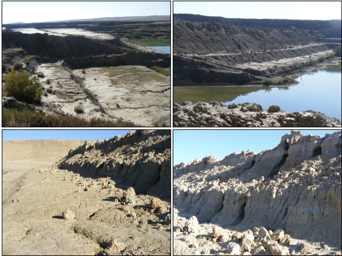
Figura 19. Erosión de los frentes de avance de la explotación de arcilla en la cantera La Paloma II
