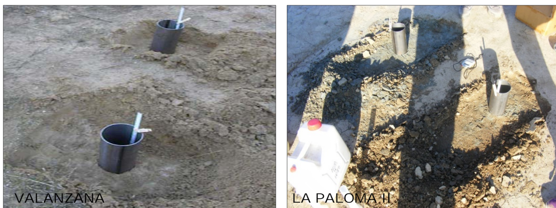
Figura 14. Ensayos para la determinación de la conductividad hidráulica in situ en el fondo de los huecos de las canteras Valanzana y La Paloma II por el método de Hatt & Le Coustumer (2008)
